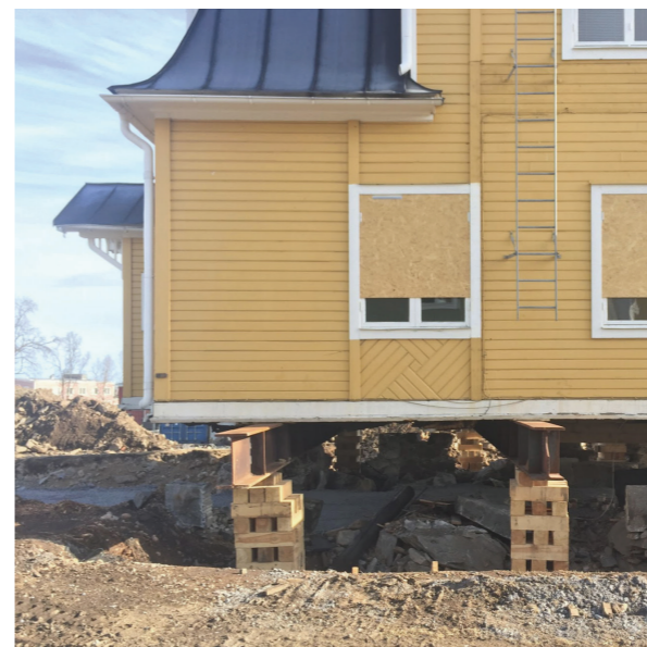
Byggnad förbereds för flytt i gamla Kiruna.
